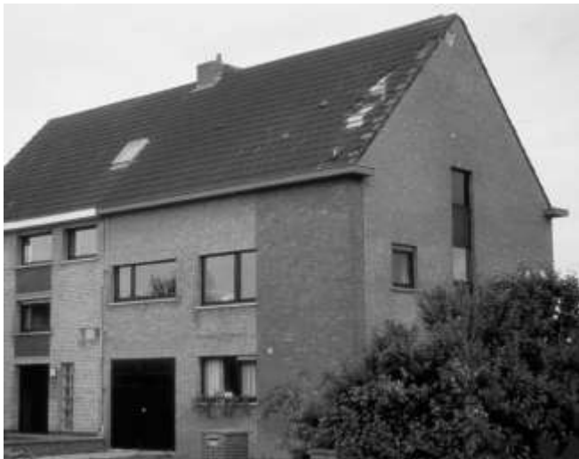
شکل ۱- نمونه‌هایی از سقف و نماهای آسیب دیده توسط آذرخش
