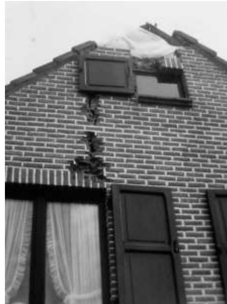
شکل ۱- نمونه‌هایی از سقف و نماهای آسیب دیده توسط آذرخش
